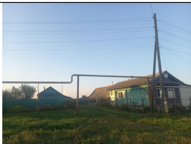
Газопровод от ул.Полевая до д.2 по ул.Шалашикова
