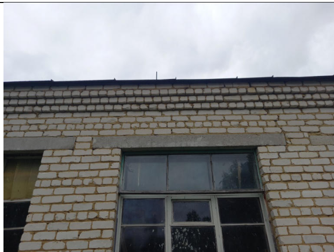
Трещина в несущей стене
